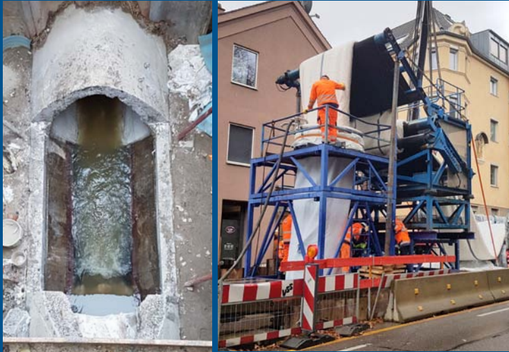
Baugrube zur Linerinversion mit geöffnetem Kanalprofil im Scheitel und eingebauten Schlauchlinern (rechts) und Baustelleneinrichtung während der Inversionsvorgangs (links)
