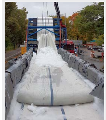
Einbau der Schlauchliner vom Tieflader mittels Kran und Förderband
