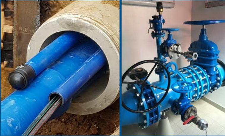
Bild links: Reinwasserleitung mit Steuerkabeln im Schutzrohr
