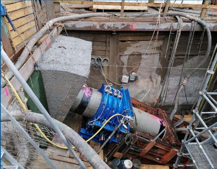
Startbaugrube mit Rohrbremse und ausgerichtetem Pressenrahmen
