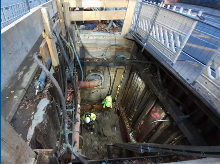
Für den barrierefreien Ausbau der Stadtbahnlinie im Hannoverschen Stadtteil Bothfeld erfolgte die Umlegung von insgesamt 296 m Regenwasser- sowie 307 m Schmutzwasserkanal überwiegend in geschlossener Bauweise.
