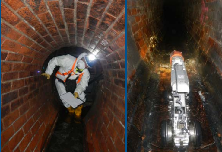
rechts: Kanalbegehung; links: Kanalinspektion mit Fahrwagen und Laserdeformationsmessung
