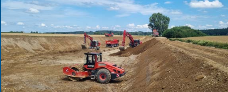
Aushub des Regenrückhaltebeckens und Herstellung der Erddämme
