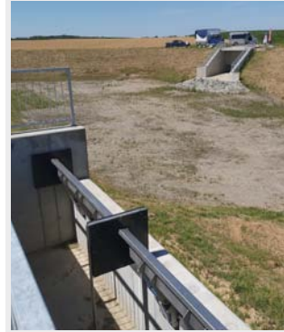
Blick vom Entlastungsbauwerk mit Federstauklappe zum Einlaufbauwerk
