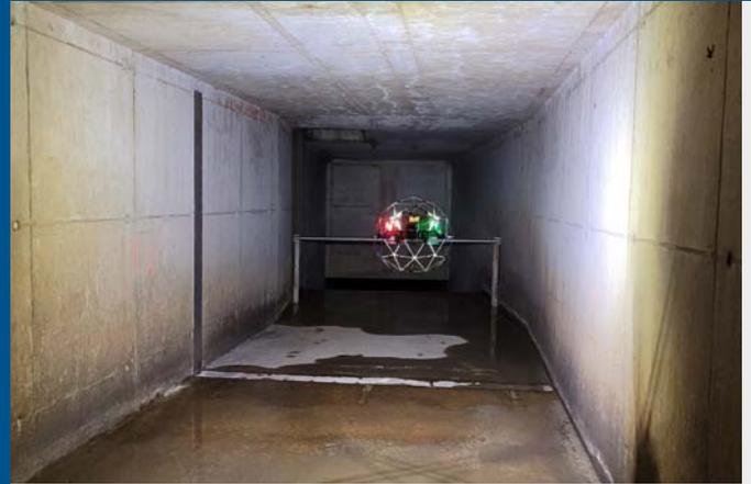
Drohne im Flugeinsatz in einem Regenauslasskanal
