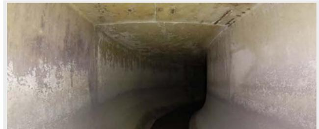
Drohneninspektion eines Sonderprofils 1800/2000
