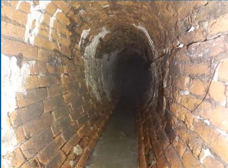
Aufnahme eines über 100 Jahre alten Mauerwerkskanals in 7 m Tiefe und unbekanntem Kanalverlauf
